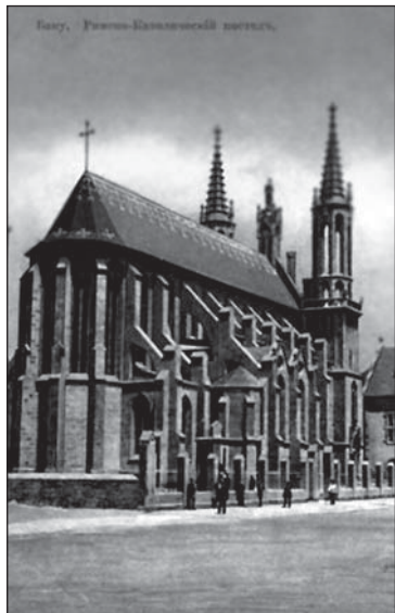
Католический костел в Баку. Фото начала XX в. Архитектор Ю.Плошко
