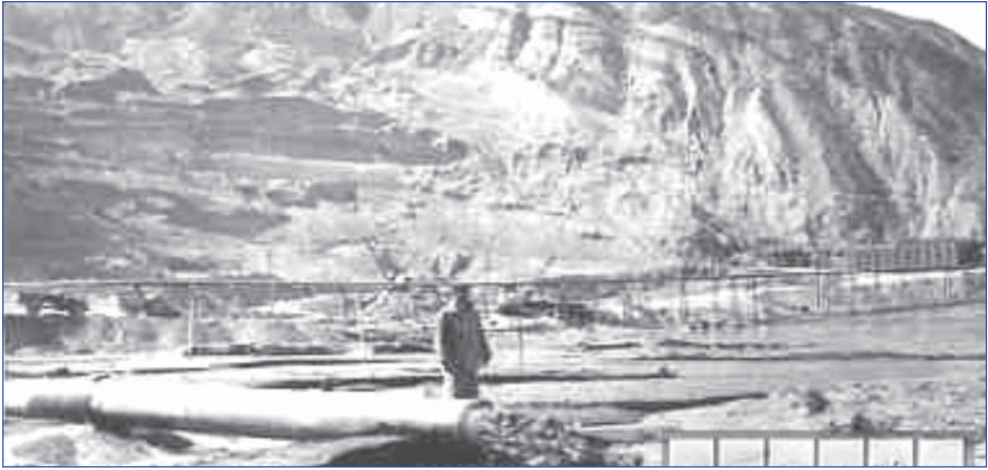
Рис. 5. Строительные работы одного из участков Мингечаурской ГЭС. Дата съемки 1953 год
