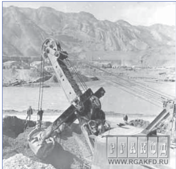
Рис. 4. Строительство Мингечаурской ГЭС на реке Кура. Дата съемки: 1950 год
